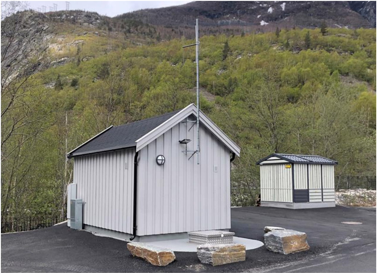
Vee Avløpspumpestasjon, Årdal kommune
