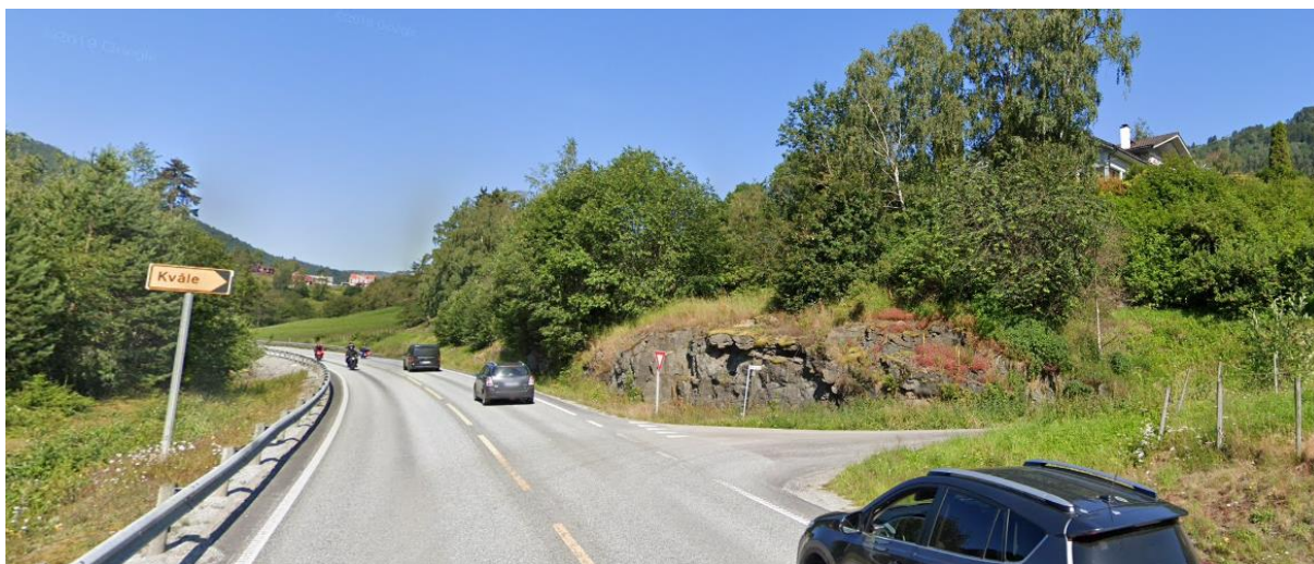
Figur 7: Fjellskjæring i eksisterende T-kryss (kilde: Google Maps)
