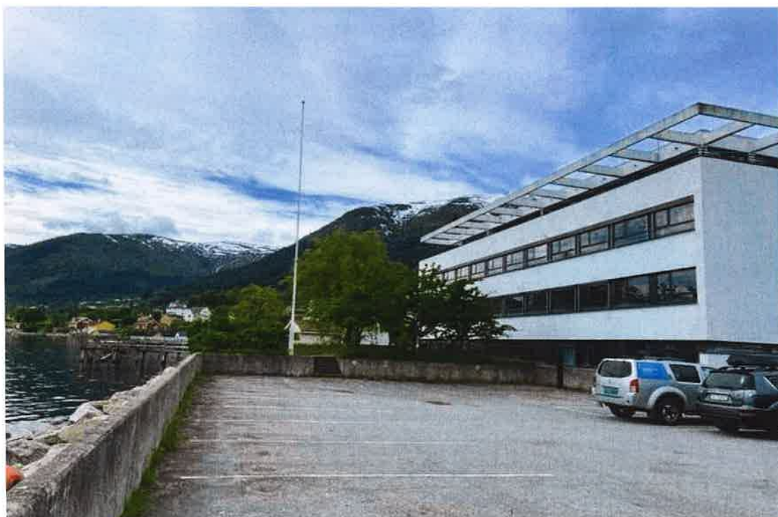
Bilder over viser parkeringareal nedside av bygning, mot sjø. Etablering av flaumveg for overvatn i venstre hjørne av parkering.
